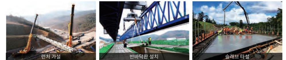
다양한 공법으로 현장 설치 후 반바닥판을 시공하여 고소작업 최소화
